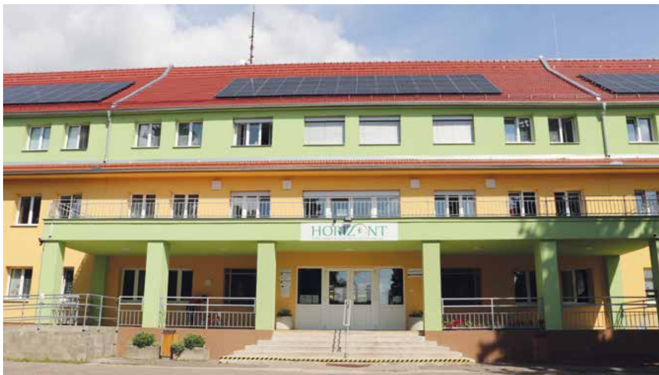
Budova Horizontu na Zemědělské ulici nedávno prošla výraznou proměnou – kromě zateplení a nové fasády má také novou střechu s fotovoltaickými panely
