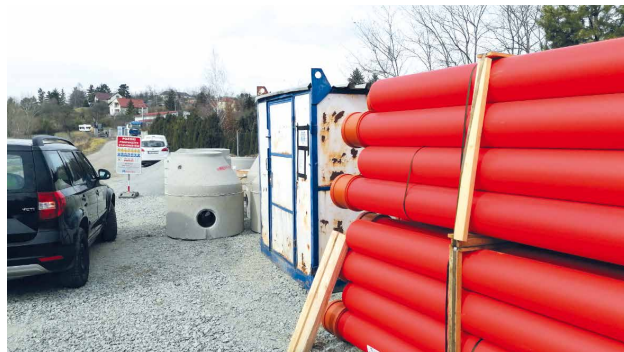
Stavba vodovodu a kanalizace v H. Pancířích
