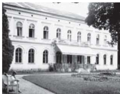
Dům v Alexovicích, který rodina Placzkových obývala v letech 1913-1939.
