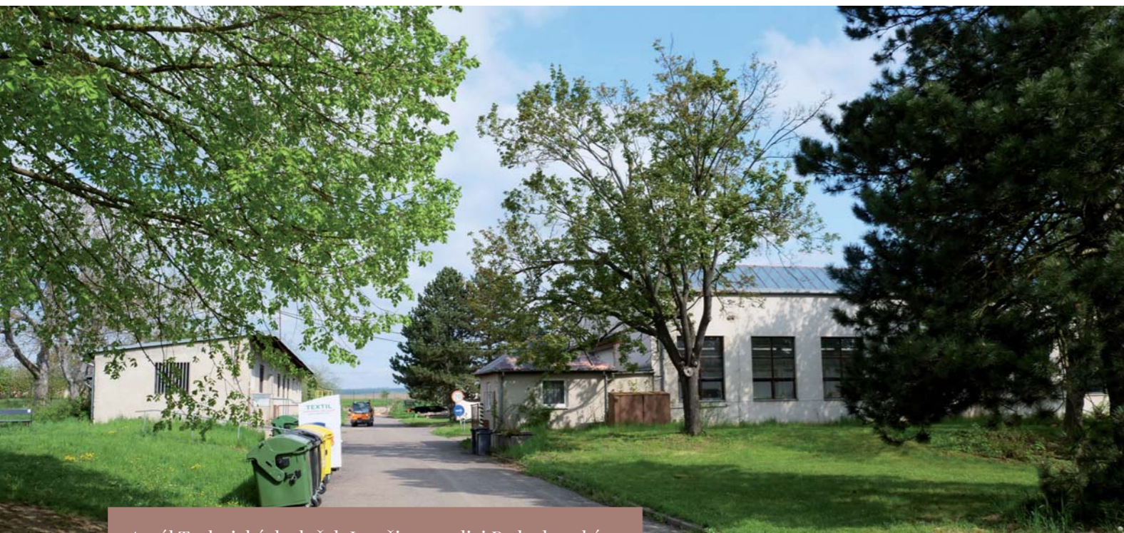
Areál Technických služeb Ivančice na ulici Padochovská 17
