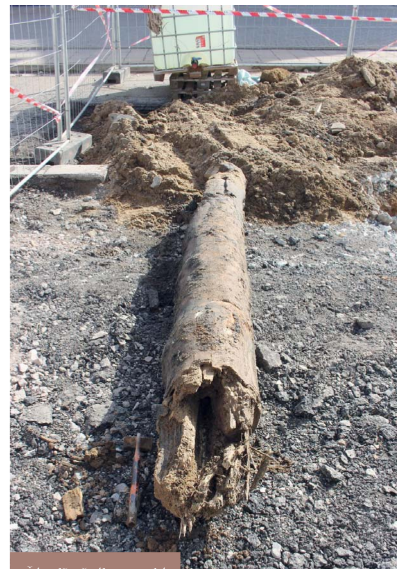
Část dřevěného potrubí
