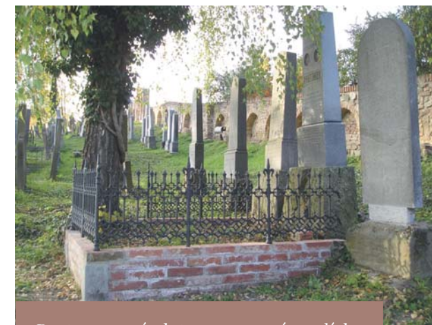
Restaurované ploty a opravená vyzdívka
