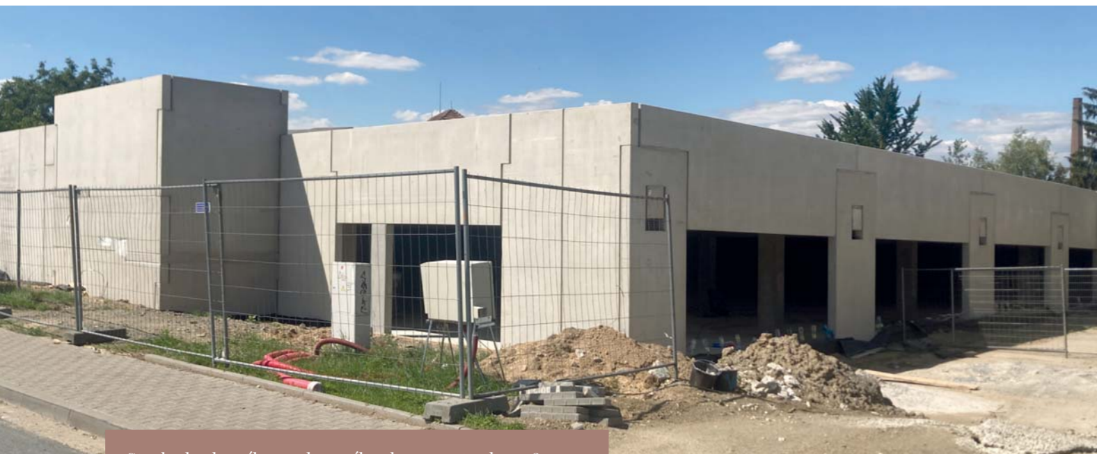
Stavba budoucího parkovacího domu – stav k 10. 8. 2022
