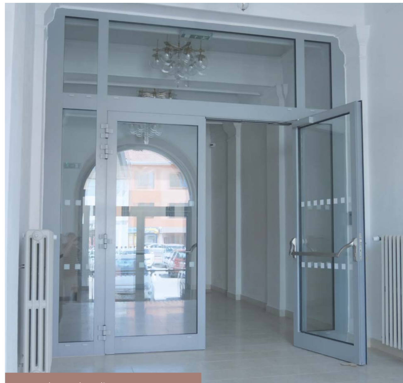
Opravený vstupní portál
