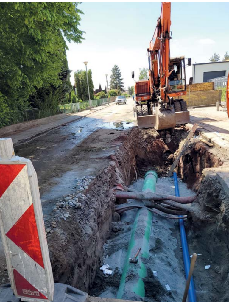
Začátek rekonstrukce kanalizace a vodovodu v ulici Petra Bezruče
