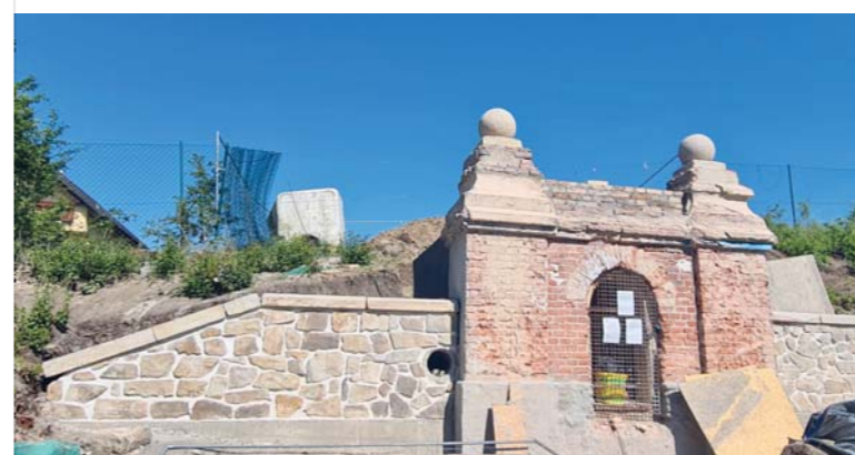
Historický vodojem báně – stav rekonstrukce v květnu
