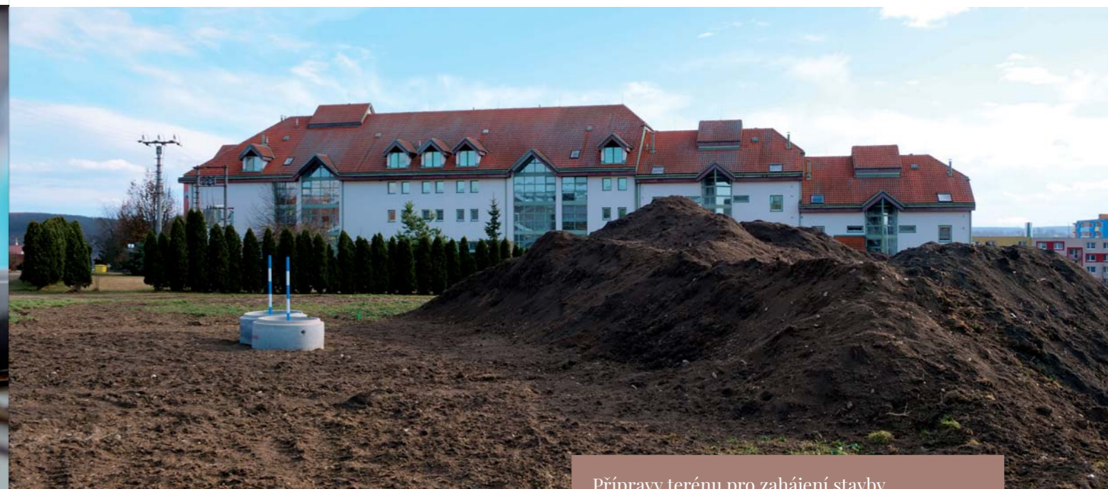
Přípravy terénu pro zahájení stavby nového domova důchodců
