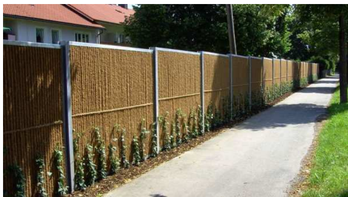
Variantní řešení úpravy kontejnerových stání – kovová konstrukce, ocelová síť, popínavé rostliny
