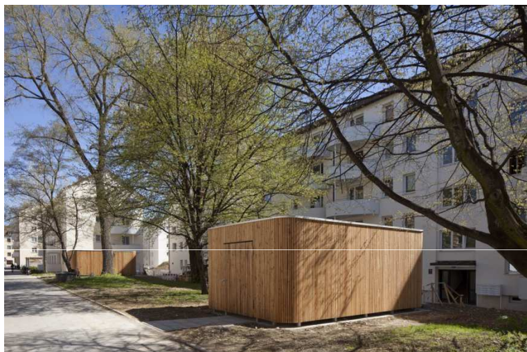
Řešení nových paravánů na odpad – kov, dřevěné latě
