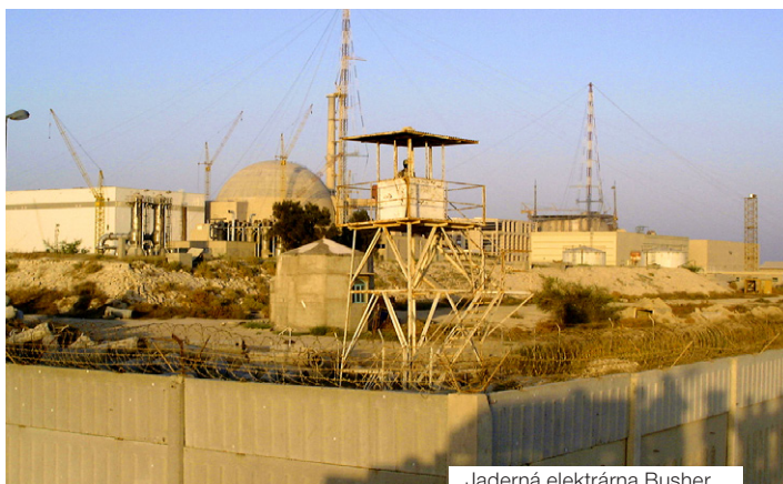
Jaderná elektrárna Busheh
