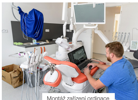
Montáž zařízení ordinace
